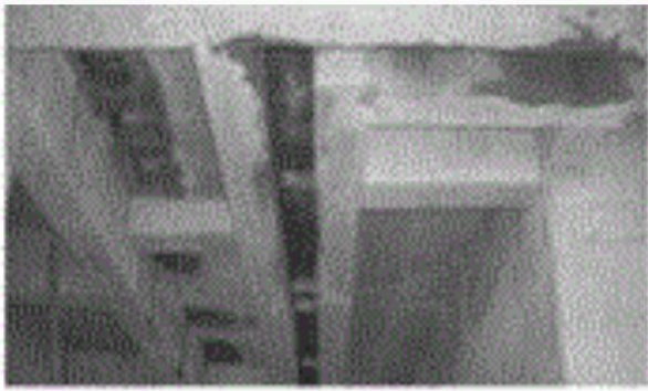
图1 房屋建筑防震缝
