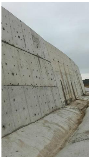
图 3-2 悬臂式挡土墙及边沟
