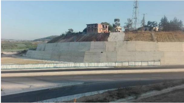
图 1-2 二级重力式挡土墙实景图
