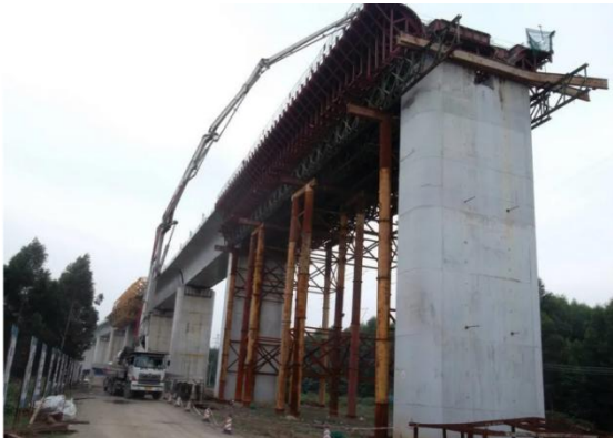
图2 公路桥梁现浇筑箱梁施工
