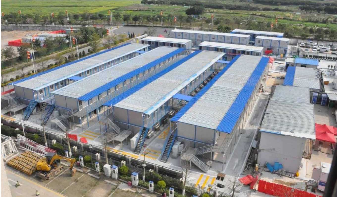
临时留观病区建设完成
