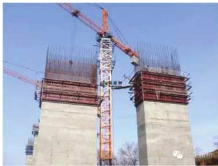
图3 公路桥梁工程高墩施工过程示意图
