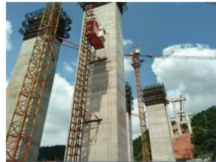
图2 公路桥梁工程高墩施工现场示意图
