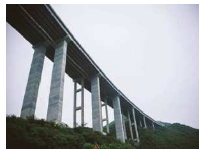
图1 公路桥梁工程高墩示意图
