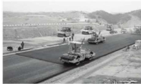
图2 分段碾压沥青混凝土路面
