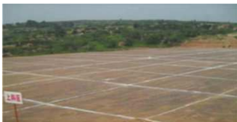
图2 对路面平整度加强控制
