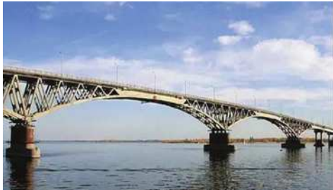
图3 混凝土悬臂梁桥
