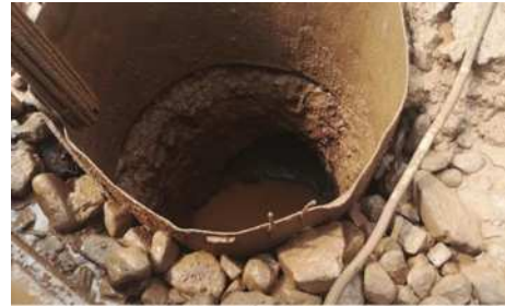
图1 塌孔示意图
