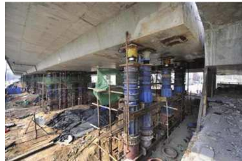
图1 注浆管线的架设安装
