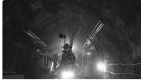
图1 锚杆支护施工
