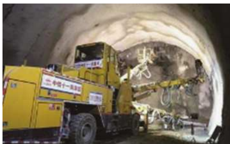
图3 钻爆打眼施工
