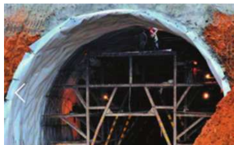
图2 隧道防水施工技术
