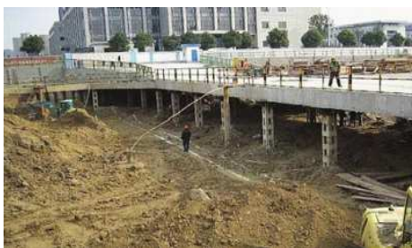
图3 深基坑施工现场示意图
