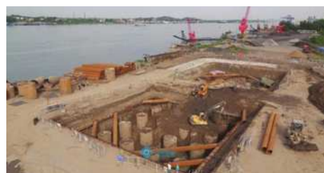
图1 深基坑施工现场示意图
