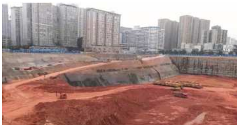
图2 深基坑施工现场示意图
