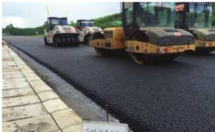
图1 压路机施工
