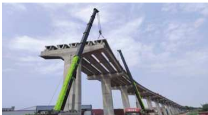
图3 桥梁预制箱梁架设施工技术
