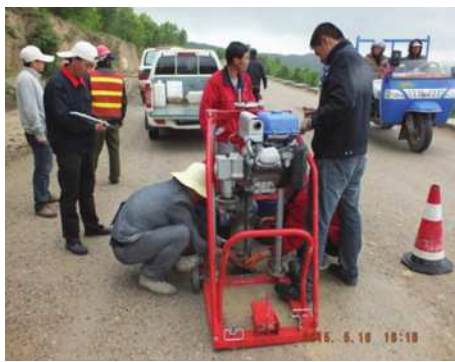
图1 施工现场工作人员
