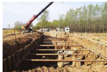
图1 道路桥梁深基坑支护施工
