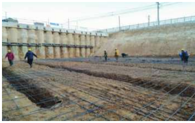
图3 边坡修理运用支护结构
