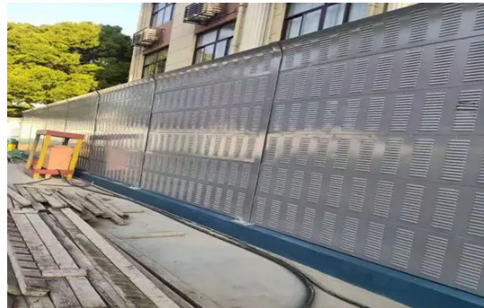
图2 工地隔音墙
