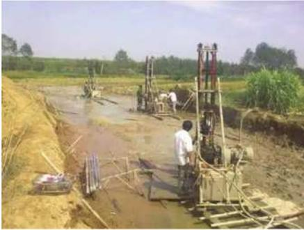
图1 粉喷桩在加固软土路基中的应用
