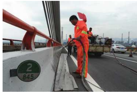
图3 桥梁养护现场图
