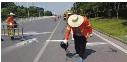
图1 公路养护现场图
