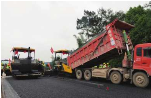
图1 公路沥青路面摊铺施工
