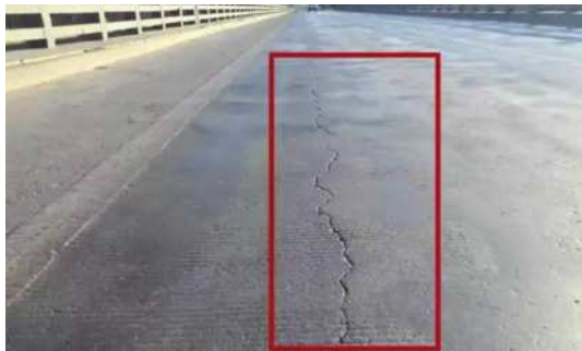
图1 桥梁裂缝
