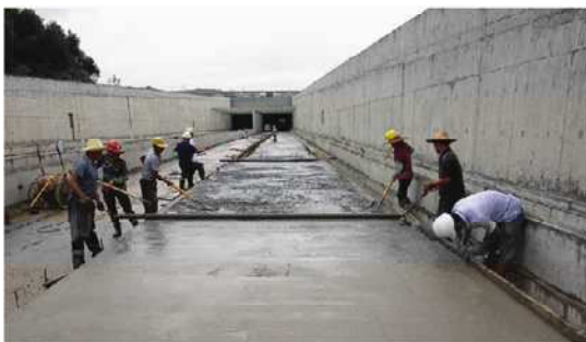
图1 道路桥梁混凝土浇筑施工
