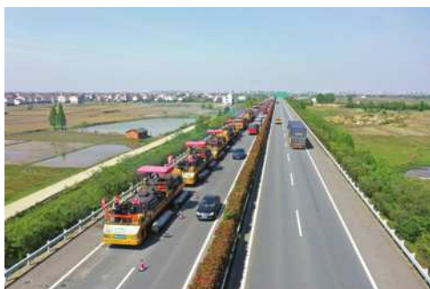
(图2 就地热再生施工现场图)
