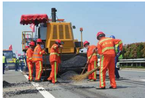
(图3 就地热再生施工作业现场)
