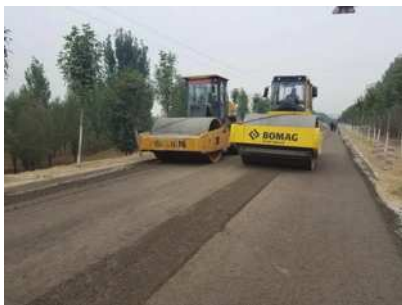
图3 公路冷再生技术施工碾压
