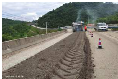
图1 公路水泥稳定碎石基层冷再生技术施工
