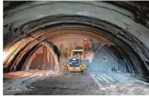
(3) 中隔墙的施工工艺是一种应用于大跨度浅埋隧洞的施工。在中隔墙施工中，隔墙每个步骤都要进行锚喷支护、钢架安装、中隔墙、临时仰拱等工序，而中隔墙则是从上到下，分两个阶段或三个阶段挖出中隔墙的一面，进行支护，再进行下一段操作。
