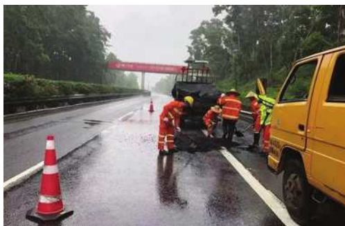
图1 雨天公路施工
