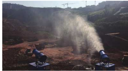
图2 土石方施工使用雾炮压尘
