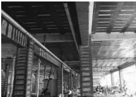
图1 混凝土结构加固技术
