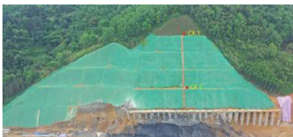
图 2 K42+800-K43+100 右侧边坡监测布置图
