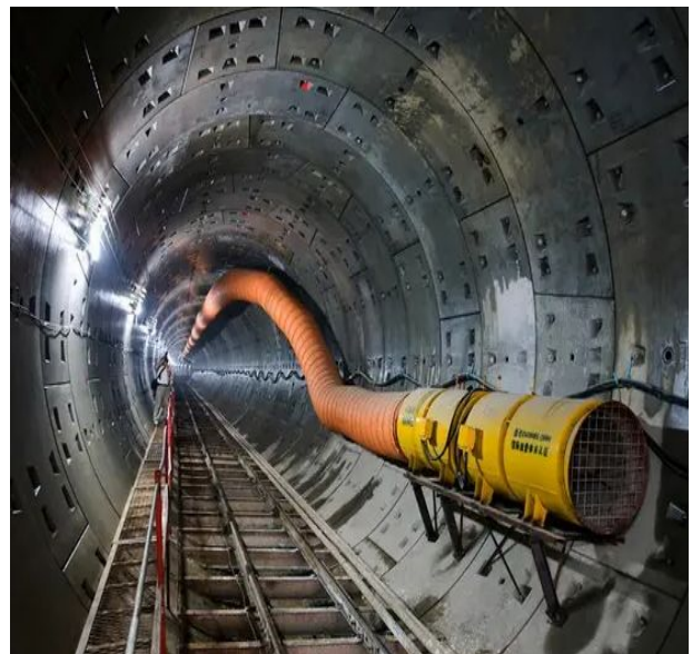
图1 地铁隧道盾构施工
