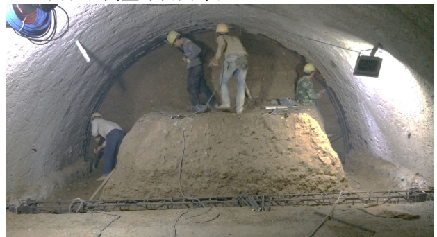
图1 浅埋暗挖隧道开挖施工图
