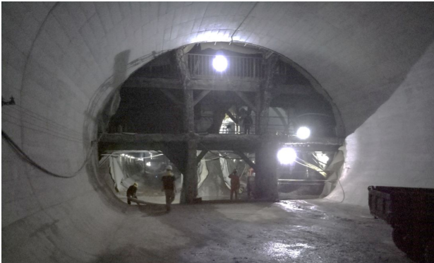
图2 双侧壁导坑法初支结构图
