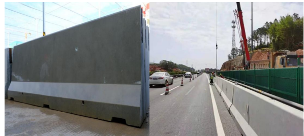
图 3 设计优化后的新泽西护栏快速吊装
