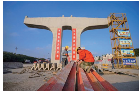
图5 盖梁拆模后效果
