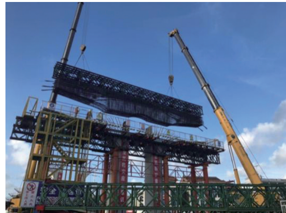
图4 钢筋整体吊装
