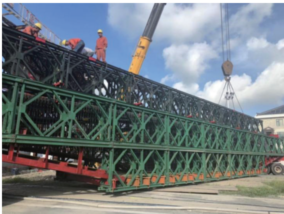
图3 钢筋整体运输
