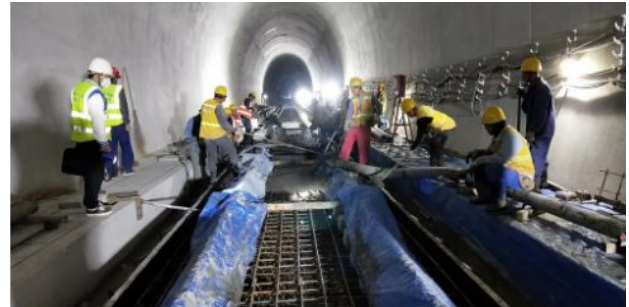
图2 城市地铁轨道道床混凝土浇筑工程
