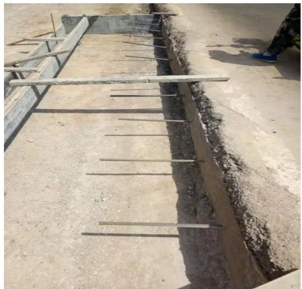
图 1 新旧钢筋搭接施工
