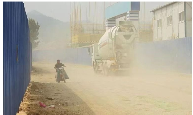
图1 道路施工产生的粉尘
