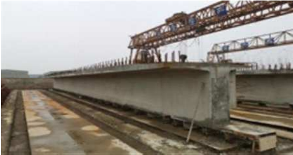
图2 预制拼装式T梁
