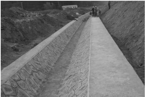
图 2 路基排水沟及边沟示意图
