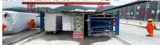
图 3 无轨液压 T 梁模板的同步拆模
