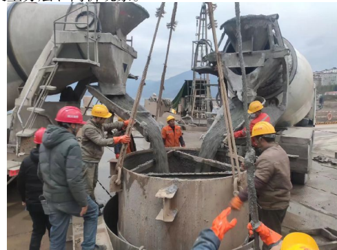
图 8 桩基混凝土浇筑 Figure 8
