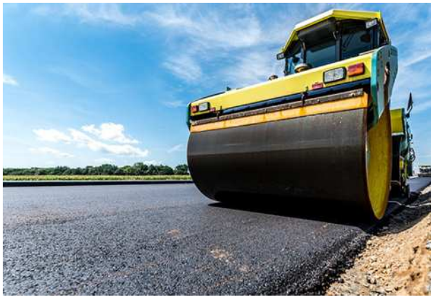
图2 路基压实施工
