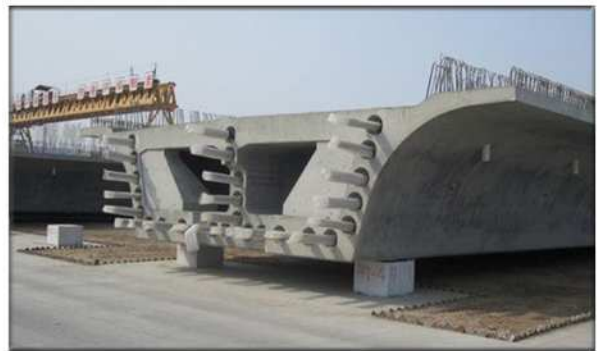
图2 桥梁孔道混凝土检验
