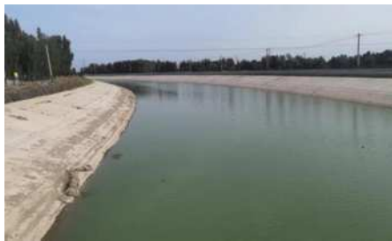
图 2 南水北调干渠现场照片
