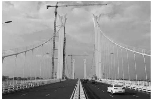
1.1 广西贵港市罗泊湾大桥主桥为大跨径混合梁自锚式悬索桥,其主塔采取国内首创的单层横梁垂直双塔结构型式;该桥首次研究应用了主塔基础“钢筋混凝土沉井结合高压旋喷防渗”施工技术、水中临时墩基础“水下混凝土扩大基础结合预应力精轧螺纹钢锚固”设计技术、钢箱梁“新步履式多点同向分段连续顶推”施工技术等3项国内首创的科技创新,技术水平国际先进,技术含量十足
