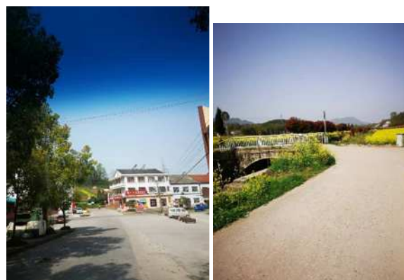
图 4 农村公路交安设施不全
