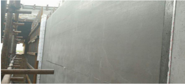
图 8 拆模后的结构物的表现质量
