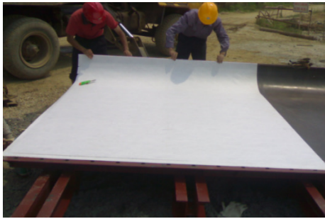
图 2 透水模板布裁剪
