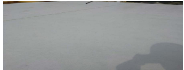
图 5 透水模板布拼接
