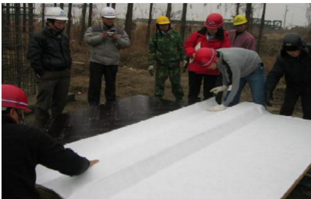
图 4 透水模板布铺设
