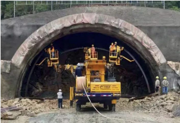
图 2 三臂架安装台车作业图
