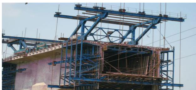
图1 现浇梁施工图片
