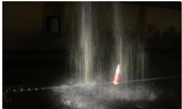
图1 公路隧道工程漏水现象图示
