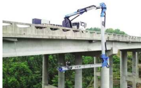
图1 高速公路桥梁检查
